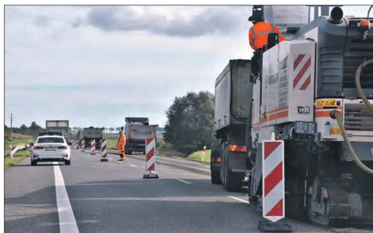
Prace na obwodnicy Lubrzy
