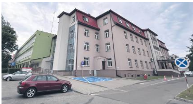
Ośrodek Interwencji Kryzysowej mieści się w budynku Starostwa Powiatowego w Tomaszowie Lubelskim (I piętro).
