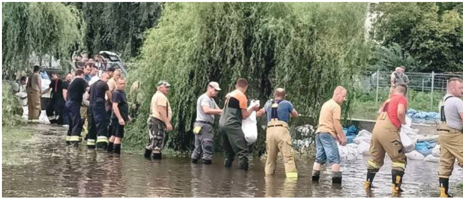
20 zastępów strażaków, w tym 3 Państwowej Straży Pożarnej i 17 OSP, układało worki z piaskiem na dawnym korycie rzeki Topornica, by uchronić przed zalaniem zamojskie zoo.
