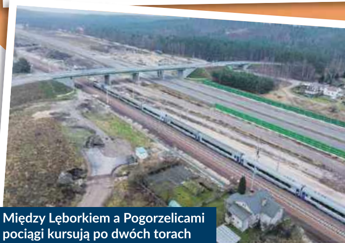
Nowy, dwukrawędziowy peron na stacji kolejowej Potęgowo
