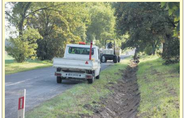
Prace wykonywane są na zlecenie Dolnośląskiej Służby Dróg i Kolei
