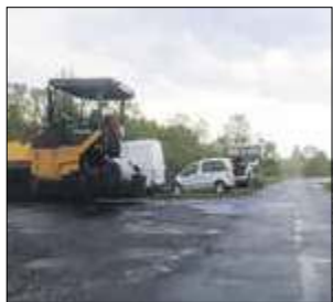
Prace remontowe obejmują roboty przygotowawcze, wykonanie warstwy wyrównawczej z betonu asfaltowego, warstwy ścieralnej z betonu asfaltowego, roboty wykończeniowe oraz wykonanie i uzupełnienie poboczy
