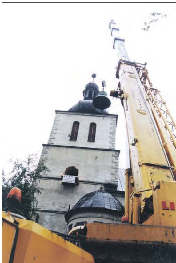
W celu ponownego umieszczenia dzwonu w ścianie wieży wybito otwór
