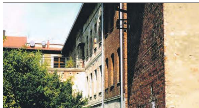
Pozostałości po fabryce a później szkole zawodowej.
