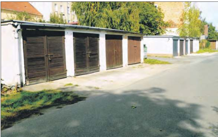
Garaże wybudowano w miejscu, gdzie płynęła „betonowa” rzeczka, w której można się było kąpać. Woda płynęła do młyna.
