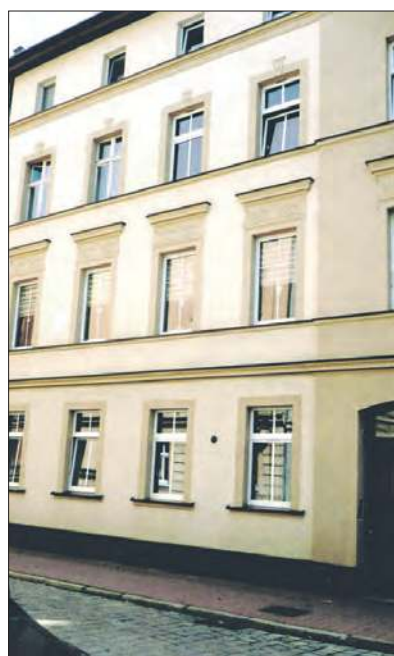
Kamienica po remoncie
