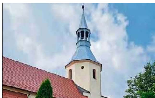
Remont wieży kościoła w Pisarzowicach. Wartość inwestycji: 186 272,15 zł.
