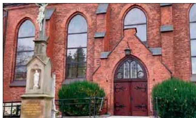
Prace konserwatorskie i budowlane elewacji północno-wschodniej oraz południowo-zachodniej kościoła parafialnego pw. Nawiedzenia NMP w Komornikach. Wartość zadania: 301 422,24 zł.
