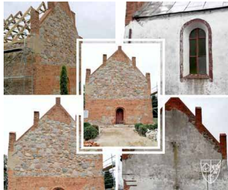
Elewacja ściany zachodniej została odnowiona, ponadto naprawiono więźbę dachu
