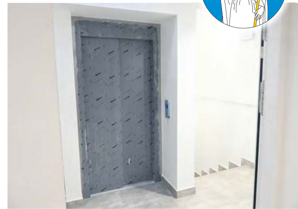
W budynku zamontowano również windę.
