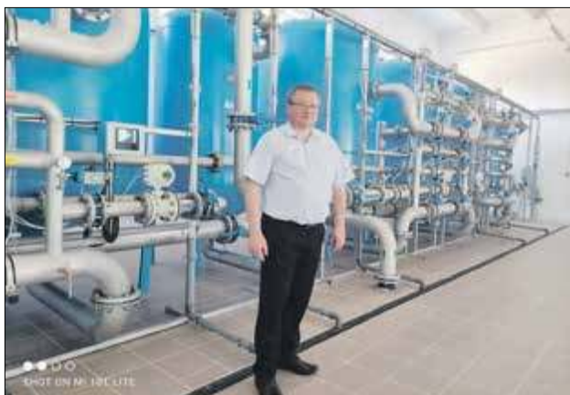
W Terespolu zmodernizowano stację uzdatniania wody. Burmistrz zapewnia, że dzięki temu woda w mieście będzie wyższej jakości i przez długi okres będzie bezpieczna dla użytkowników
