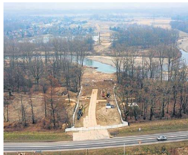
W kwietniu rozpocznie się budowa ronda związanego z obwodnicą Oświęcimia w rejonie ul. Legionów
