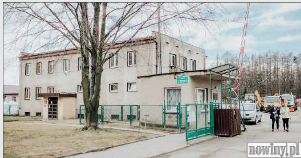
Przebudowę Punktu Selektywnej Zbiórki Odpadów przy ul. Markłowickiej ma zostać objęty dotychczasowy budynek gospodarczy. Zadanie obejmie również modernizację infrastruktury towarzyszącej oraz zakup sprzętu.
