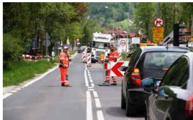
Ruszył remont drogi wojewódzkiej w Krościenku.
