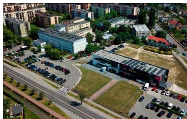
Widok szpitala po wyburzeniu części blaszaka (2021 rok).
