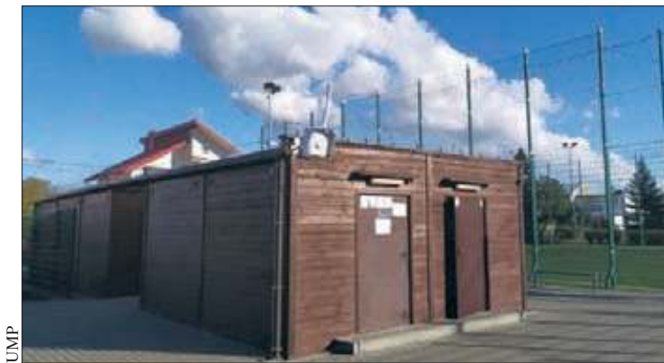
Jeden z mierników został zainstalowany na szatni Orlika przy ul. Zamenhofs na Winiarach
