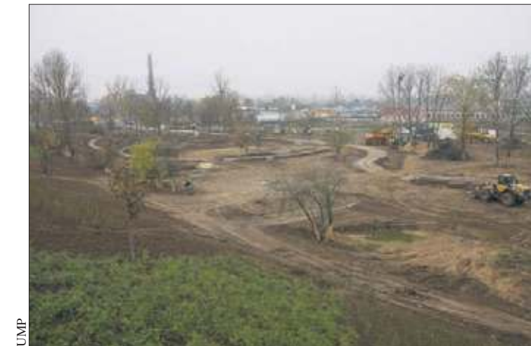
Już widać zarys nowych alejek parkowych na placu Mościckiego
