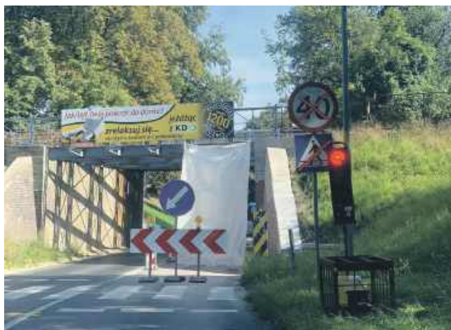
Jeszcze w tym tygodniu w okolicy wiaduktu kolejowego na Wrocławskiej prowadzone były prace. Wprowadzono ruch wahadłowy
