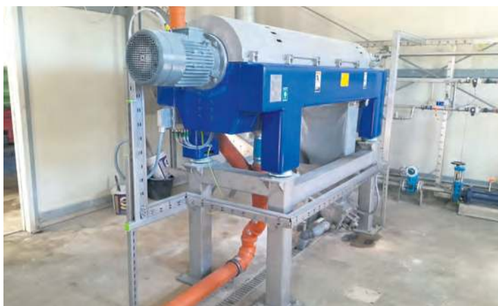
Wirówka dekantacyjna z osprzętem do odwadniania i higienizacji osadów.
