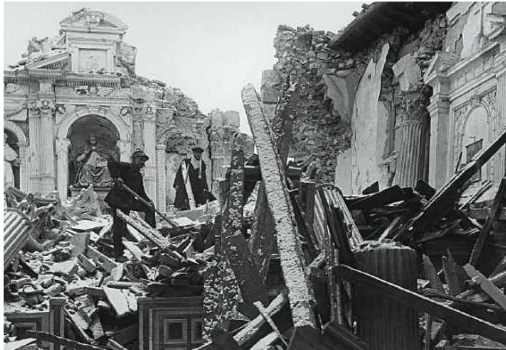
• W 1915 r. kościół św. Piotra zniszczyło trzęsienie ziemi. W latach 1955-1957 został odbudowany. Wykorzystano oryginalne fragmenty i przywrócono mu romański charakter
