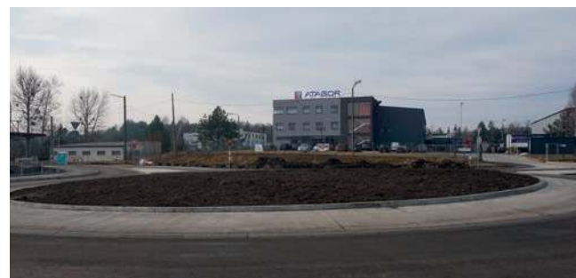
Przebudowa ul. Wodzińskiej w Chrzanowie i ul. Sikorskiego w Trzebini, budowa nowych rond w tym ciągu oraz nowego odcinka drogi w kierunku Orlen Południe (łącznik do ul. Fabrycznej i ul. Kwiatowej w Trzebini)
