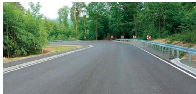
Przebudowane „serpentyń” łączące Alwernię i Grojec
