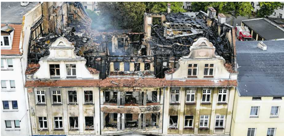
• Kamienica na ul. Kraszewskiego zaraz po pożarze
