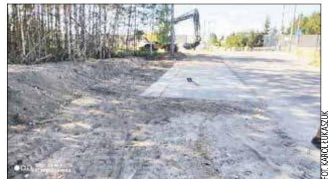
Budowa dobiegła końca, z parkingu można już korzystać
