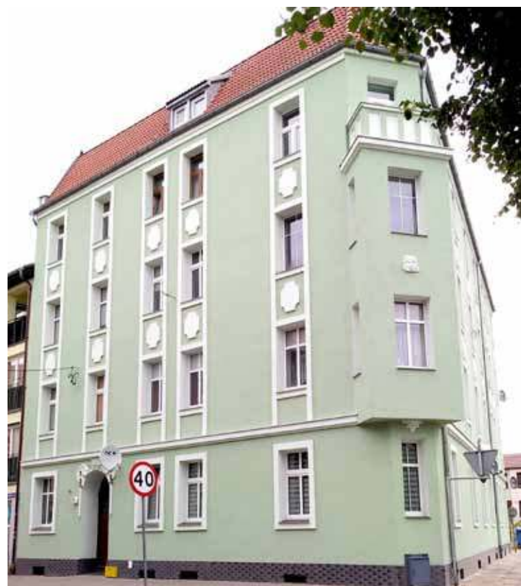
Ponad 500 tys. zł kosztowała termomodernizacja kamienicy przy ulicy Wojska Polskiego 77
