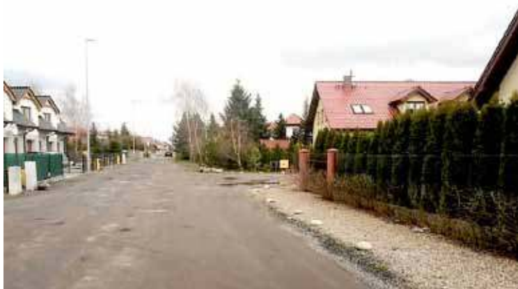
Na ulicy Leśmiana pojawi się nawierzchnia bitumiczna i z kostki betonowej co wpłynie na poprawę komfortu jazdy
