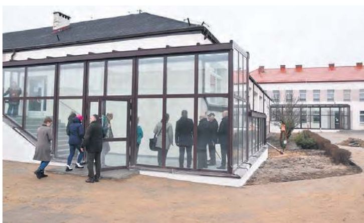
Łącznik przy Gminnej Bibliotece Publicznej.
