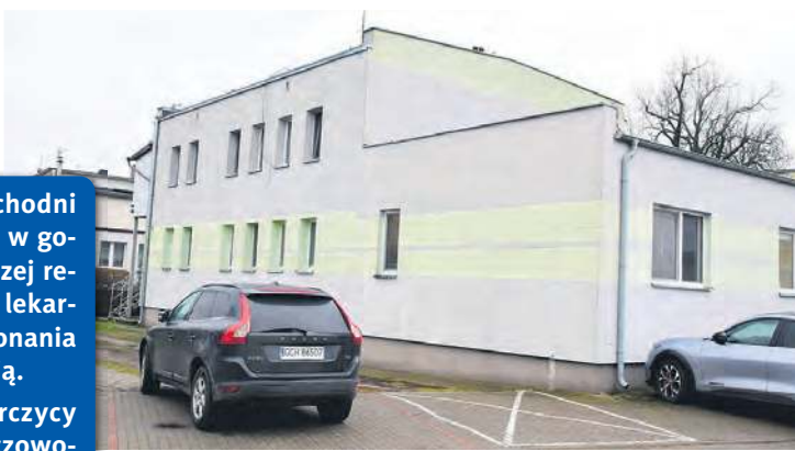
Obiekt przychodni jeszcze w tym roku ma zostać rozbudowany. Nowa część, licząca ponad 110 m², będzie niejako przedłużeniem rehabilitacji.
