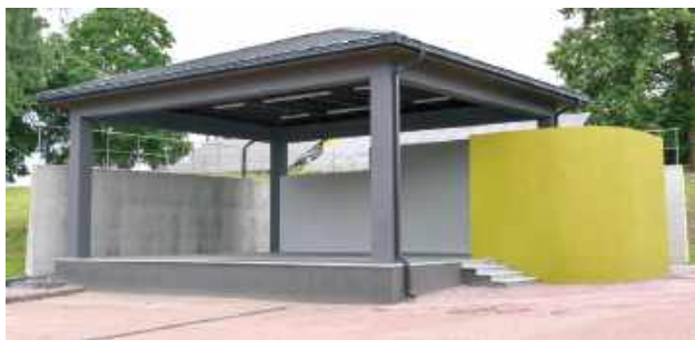
Dzięki nowo wybudowanej scenie Gminny Ośrodek Kultury i Biblioteka w Ułężu, który dysponuje już wyremontowanym budynkiem głównym oraz zmodernizowaną salą widowiskową, staje się kompletnym i w pełni funkcjonalnym obiektem kultury, przygotowanym do organizacji szerokiego spektrum wydarzeń plenerowych na wysokim poziomie technicznym
