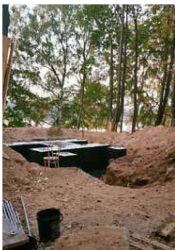
Nad jeziorem Ińsko trwa budowa wieży widokowej
