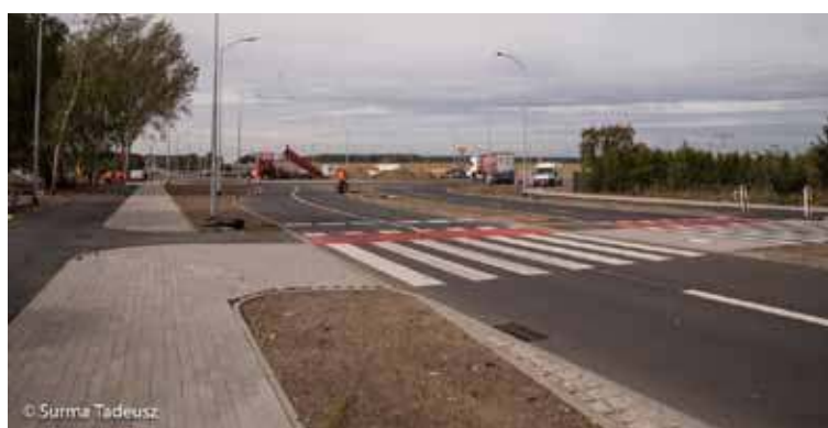
Zakończyła się budowa ronda w Lipniku
