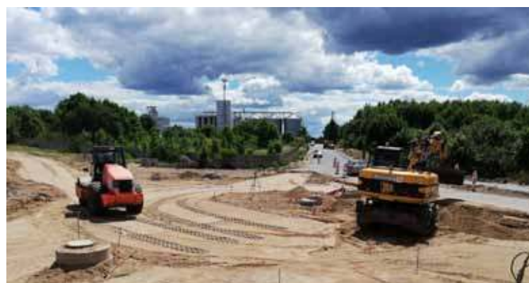
Droga nr 151 biegnąca przez Ińsko do Ciemnika doczekała się remontu fot. PRD Nowogard
