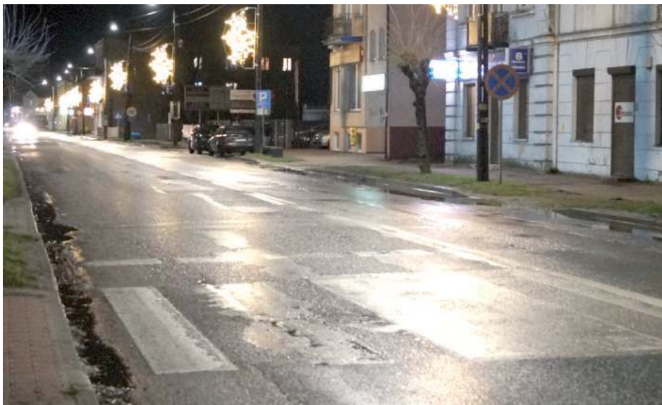
Remontu doczeka się odcinek drogi ul. Lubelskiej
