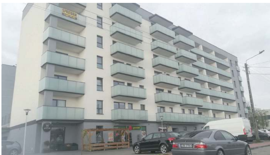
Budynek wielorodzinny przy ul. Armii Krajowej wybudowany przez firmę TAP-BUD Andrzeja Tarkowskiego od początku jest powodem dużego zainteresowania mediów i opinii publicznej
