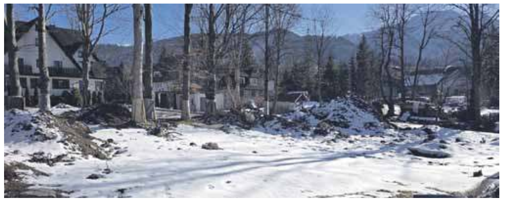
Budowa miasteczka rowerowego stanęła w martwym punkcie.
