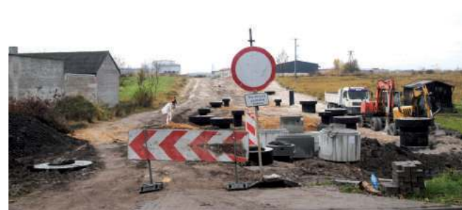
Drogowców spotkać można w rejonie ulicy Fabrycznej. Zaczęli od budowy kanalizacji deszczowej
