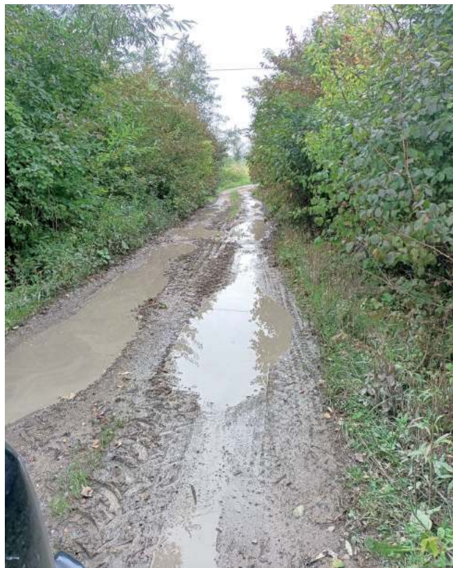
Na utwardzenie czeka ostatni 200-metrowy odcinek drogi. Po deszczu zamienia się w wielkie bagno utrudniające przejazd. Rolnicy, aby ominąć błoto, jeżdżą coraz dalej w łąki, tworząc kolejne nieprzejezdne koleiny
