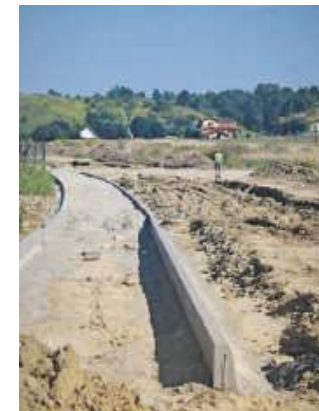
Na przebudowę opracowano projekt zamienny. Mieszkańcy i radny pytają: "po co"?
