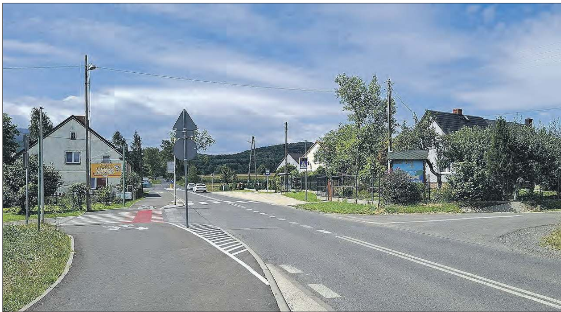
Zmodernizowana droga powiatowa w Moszczance
