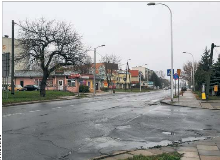
Trwają przygotowania do przebudowy ulicy Spółdzielczej
