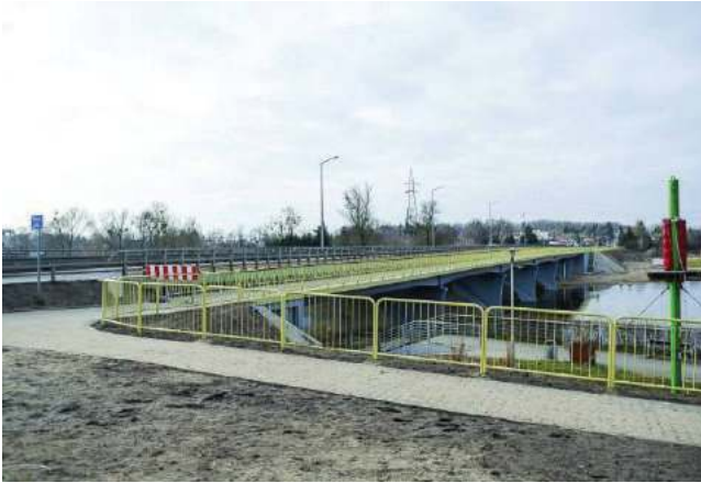
Jednym z przykładów inwestycji za unijne pieniądze jest kładka pieszo-rowerowa w Pomiechówku
