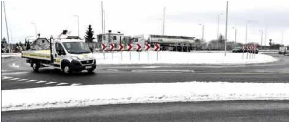
Rondo na skrzyżowaniu obwodnicy z ul. Terebelską oraz rondo na skrzyżowaniu drogi krajowej nr 2 z Al. Solidarności są bliźniaczymi rondami turbinowymi
