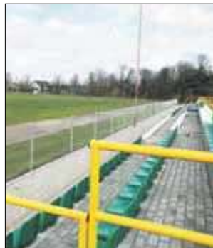
W ramach inwestycji m.in. wyposażono boisko w bramki aluminiowe, wiaty dla zawodników rezerwowych oraz wyremontowano trybuny na 300 osób.
