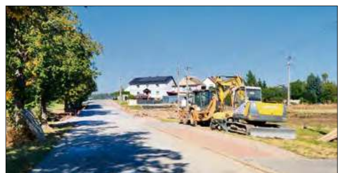
W efekcie na fragmencie drogi już w czwartek po południu pojawił się ciężki sprzęt.
