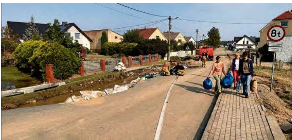
Zniszczenia na ul. Prudnickiej w Łowkowicach.
