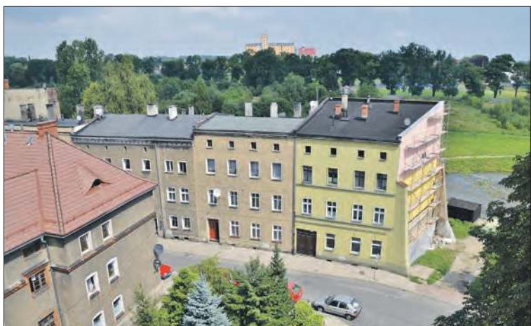
Jedną z przyszłorocznych inwestycji gminy będzie przebudowa ulic: Chrobrego, Ogrodowej i Kochanowskiego
