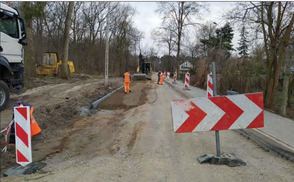
Łącznie na terenie gminy zmodernizowano około 17,5 km dróg. Wartość całego projektu zamknęła się kwotą blisko 14,1 mln zł
