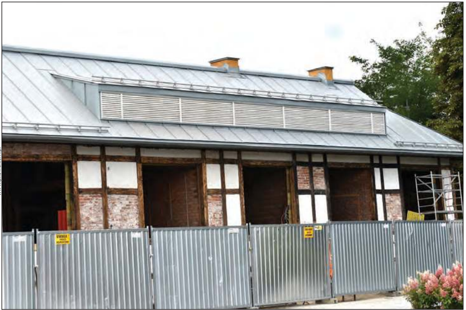
Obecnie trwają prace przy kominach oraz przy renowacji elewacji budynku, gdzie wykonywane są nowe tynki i konserwowane są drewniane elementy konstrukcyjne
