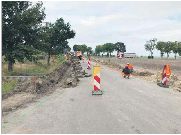
W tym roku Gmina Łomazy postawiła na budownictwo drogowe
