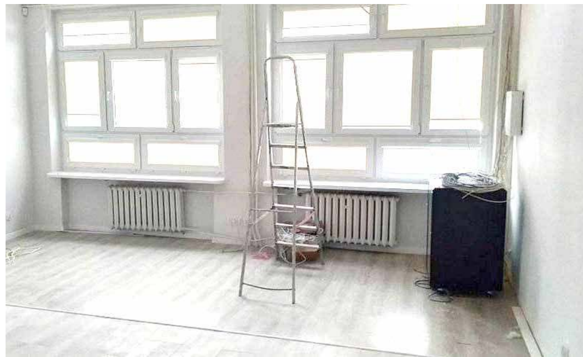
Remont pod nadzorem nauczycieli prowadzą uczniowie III klas technikum o kierunkach budowlanych, w ramach praktyk zawodowych.
