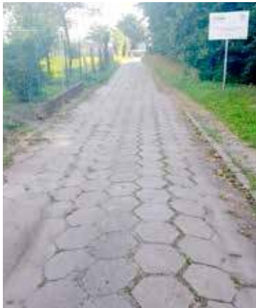
Tak droga wyglądała przed pracami remontowymi (fot. Gmina Maszewo)
