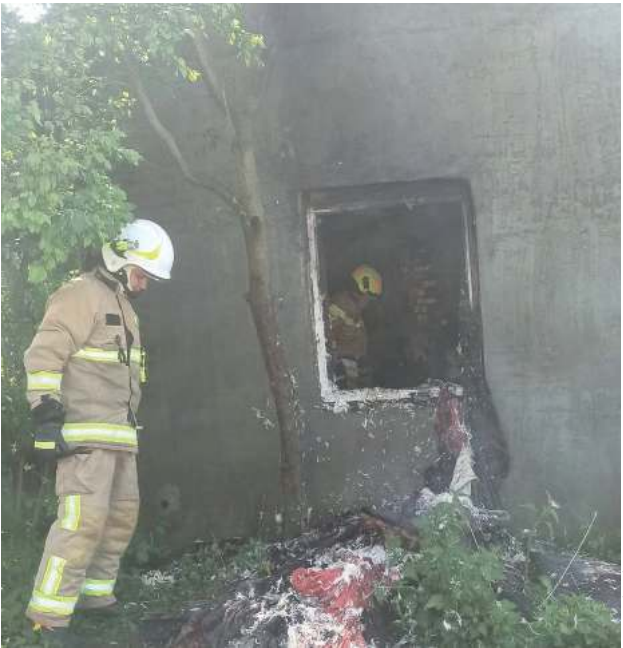
Pożar budynku w Oszczepalinie II
