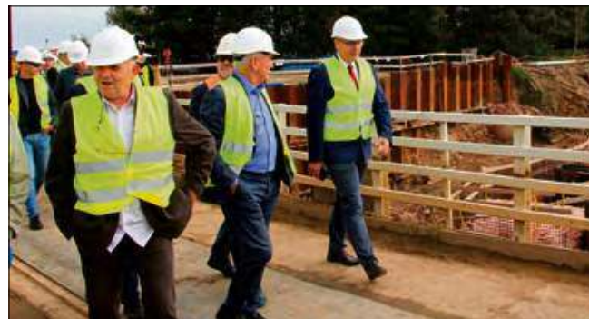
Postęp prac budowlanych na stopniu wodnym w Krapkowicach przyglądał się m.in. zastępca burmistrza Krapkowic Arnold Jozsko.
