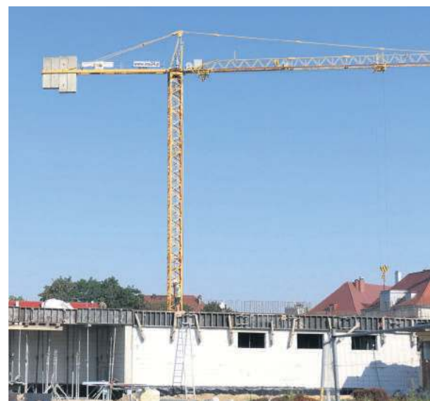
Dźwig na budowie ma około 35 metrów wysokości, a zasięg jego ramienia to pięćdziesiąt metrów. Maksymalny udźwig wynosi pięć ton
