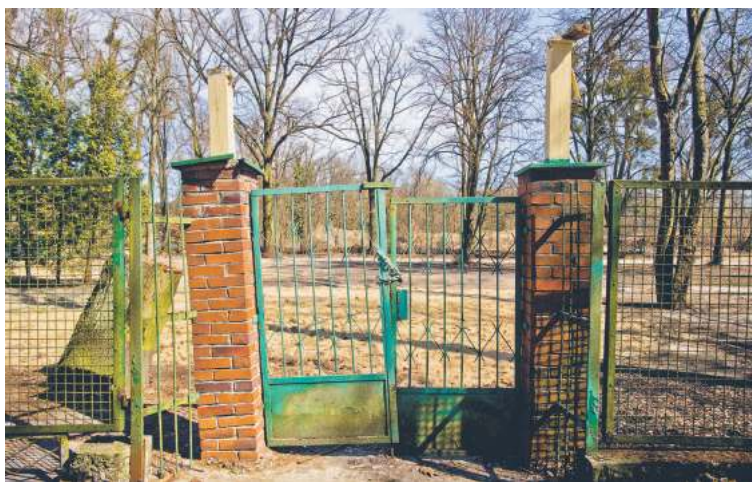
Budynki gastronomiczne i pozostałe urządzenia, które służyły mieszkańcom, zostały wyburzone | fot. Jan Środa/Gazeta Polska
