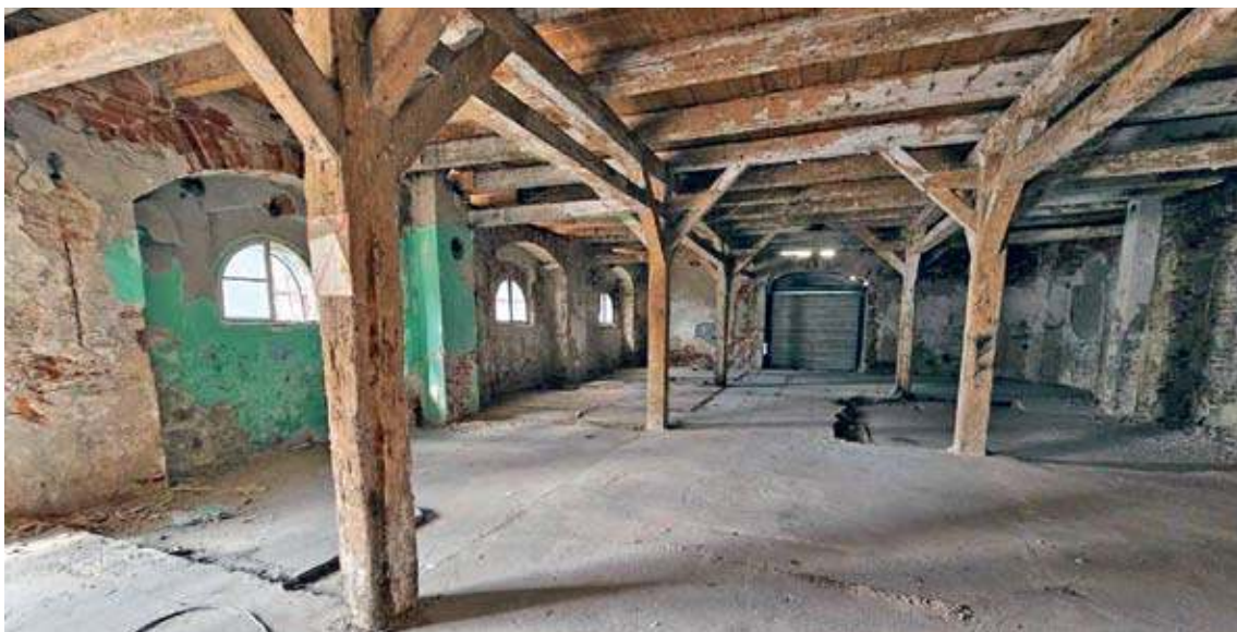
Prace budowlane już ruszyły. Na efekt końcowy trzeba trochę poczekać
