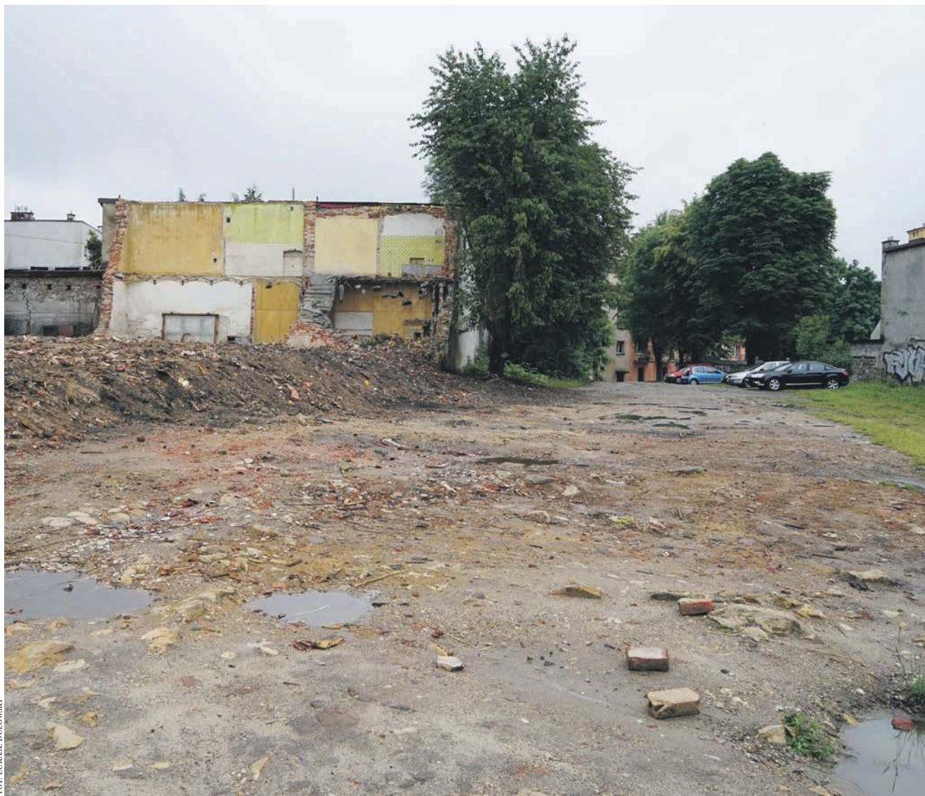
Nowa droga połączy ul. Kadłubek i 29 Listopada w Chrzanowie. Z lewej prywatny teren po wyburzonych obiektach
