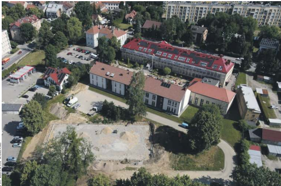
Przy ZSP w Krzeszowicach powstaje boisko. Dach na starej części obiektu jest już wymieniony
