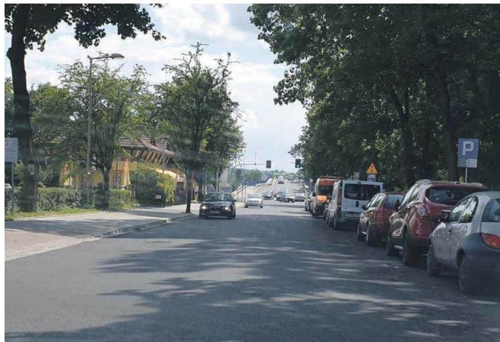
Na ul. Daszyńskiego i Ogrodowej będzie jeszcze malowane oznakowanie poziome
