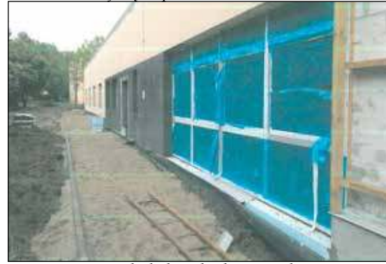
Nowa część przedszkola w budowie. Rok 2013
