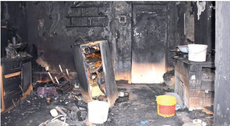
Całkowicie spłonęło jedno pomieszczenie, drzwi wewnętrzne, meble, lodówka, ubrania...
