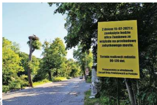
Na czas remontu ulica Zamkowa zostanie zamknięta
