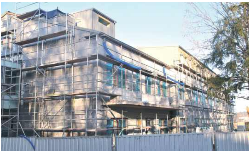
Wykonawca zgodnie z umową ma czas na zakończenie budowy i zagospodarowanie terenu do kwietnia 2026 roku. Patrząc po tempie prac, widać, że powinny zakończyć się znacznie wcześniej
